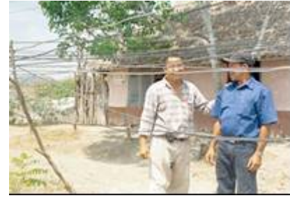
Figura 7. Cables eléctricos a la altura del cuerpo en Sincelejo
